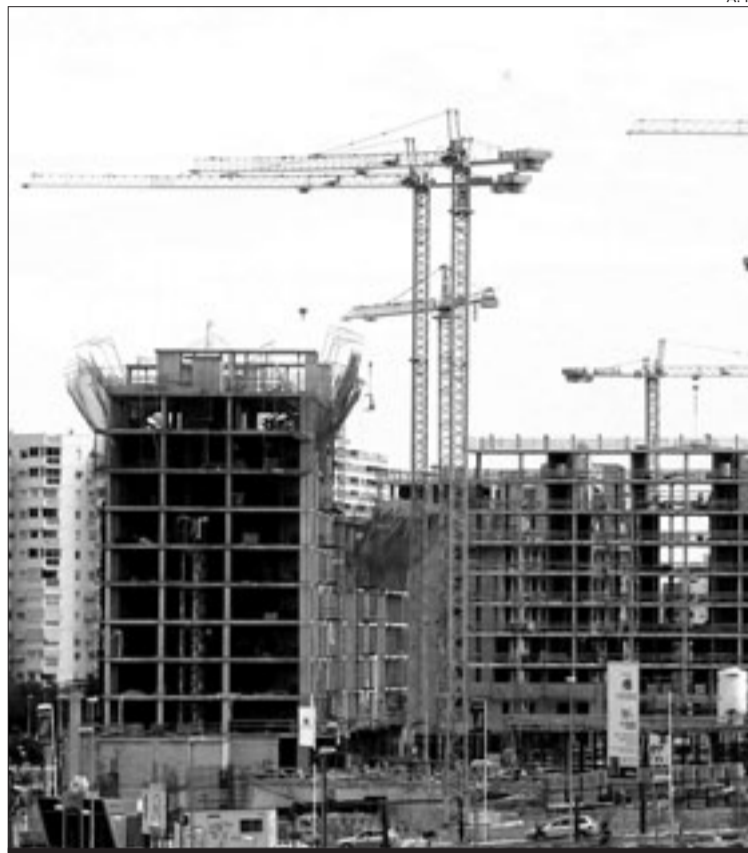
Imagen de un edificio en construcción en la ciudad de Alicante
